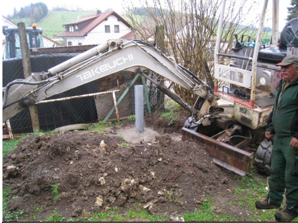
Bernd Keppler beim Einbetonieren des Rohrs
