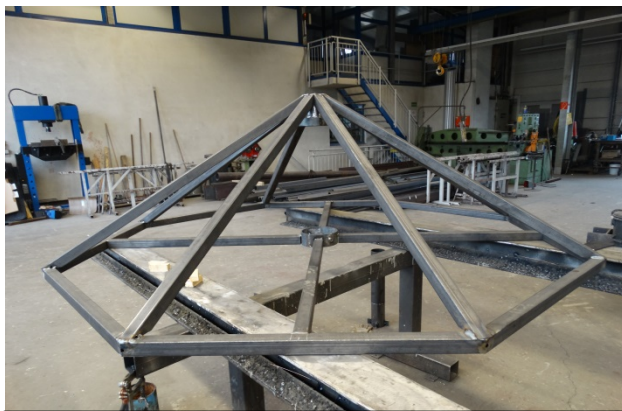
Das Gerüst entsteht bei Fa. Füllemann Metallbau
